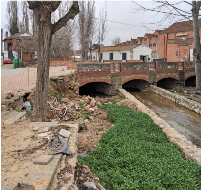
Se acometerá la ejecución de un muro de hormigón armado, chapado en piedra mampuesta igual a la existente y reposición de acera, barandilla y línea de alumbrado público
